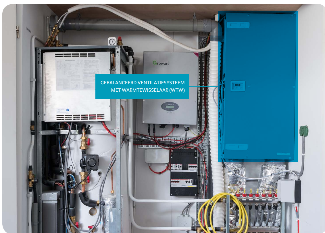
FIGUUR 5: GEBALANCEERD VENTILATIESYSTEEM MET WARMTEWISSELAAR (WTW)
